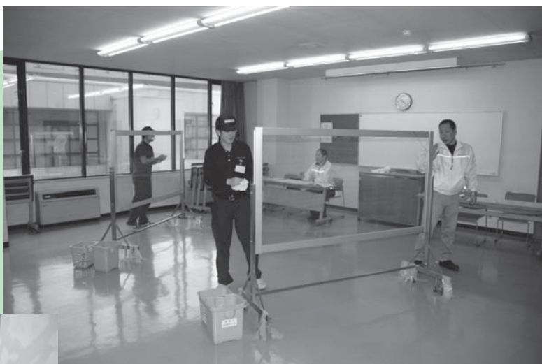
ガラス面洗浄作業
