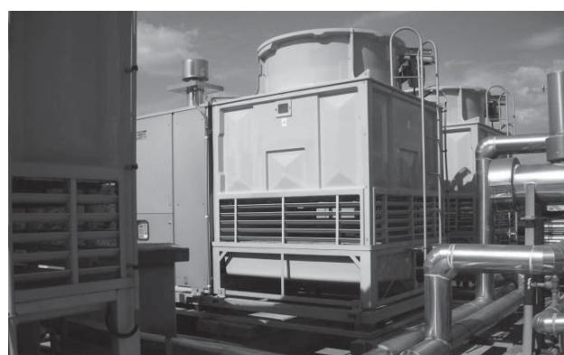
冷却塔1台当たりの水の蒸発量が半分になれば冷却塔周囲の湿度も下がる。
