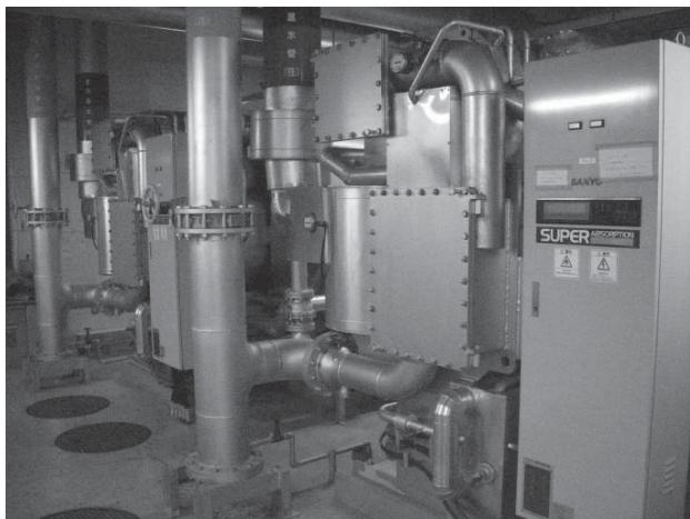
1台の吸収式冷温水機を冷凍能力以上の冷房負荷で運転すると、設定した冷水出口温度を維持できなくなり、冷水温度が徐々に上昇するとともに、冷房中の室内温度も上昇する。
