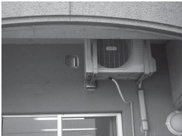
この写真のように排気口が室外機に近ければ排気の熱を効率良く回収することができるが、既存の建物では排気位置の移設は無理だろう。
