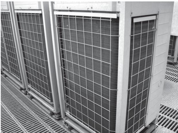
ファンが上部にあって、放熱器はその下の本体側面にある訳だが、このような構造で放熱器全面に、均等に空気が流れるのだろうか。
