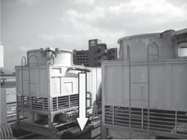
オーバーフローさせる方が簡単ではあるが、下部水槽の水位が高いので、冷却塔停止時に冷却塔上部水槽の水が下部水槽に落ちて来ると全てがオーバーフローしてしまう。
