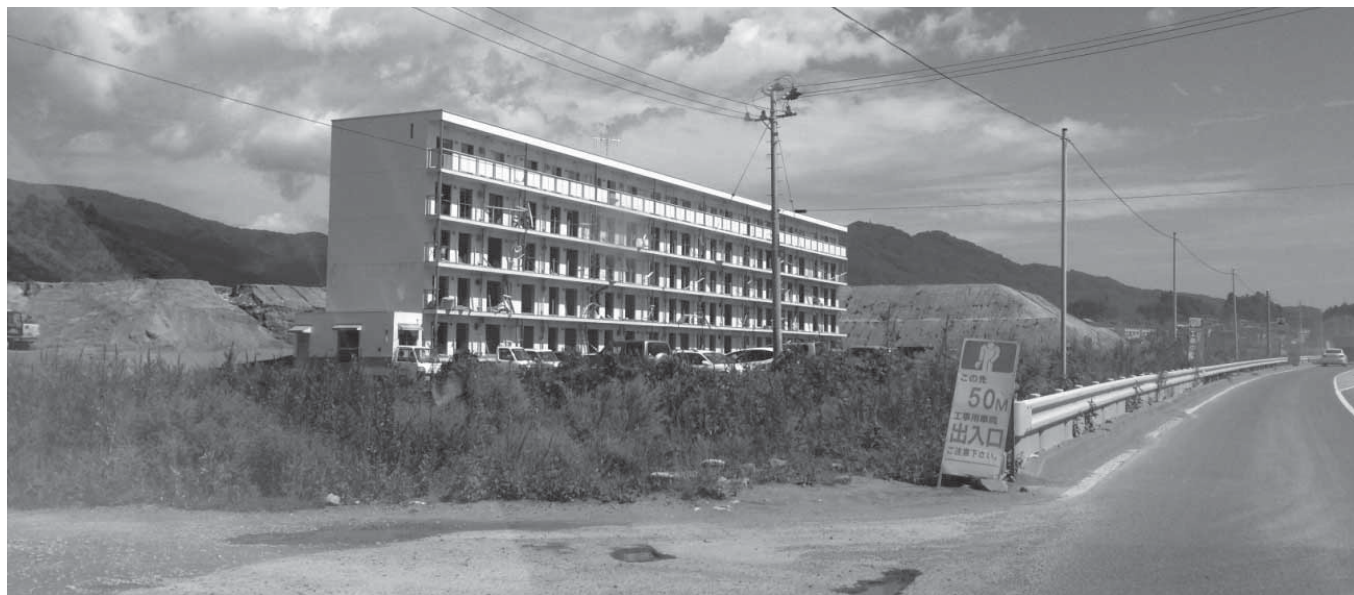
残された市営住宅の横ではかさ上げ工事が進む
