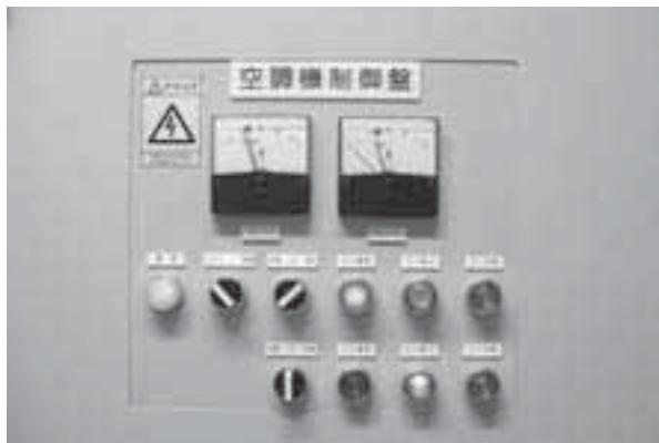
電流計は左がSAファン、右がRAファン。下段にあるRA運転の表示ランプが消えて、RA停止のランプが点灯している。RAファンを停止させて、SAファンだけで空調をおこなっているのが、電流計の指針で確認できる。
